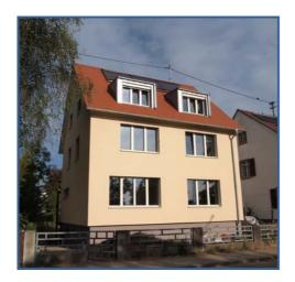
Das freistehende Einfamilienhaus wurde im Jahr 1937 erbaut. Es befindet sich in Karlsruhe Weiherfeld und umfasst eine Wohnfläche von 186 m². Durch die 2016 durchgeführte Sanierung wurde nahezu Passivhausstandard erreicht. Bei der Sanierung des Gebäudes wurde besonders viel Wert auf die Nutzung nachhaltiger Baumaterialien gelegt.
